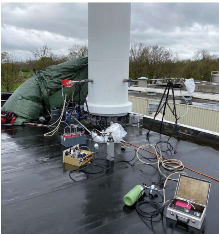
Foto meetpunt en meetopstelling
