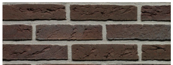
Materiaal- en kleurgebruik aan de provinciale weg N279
